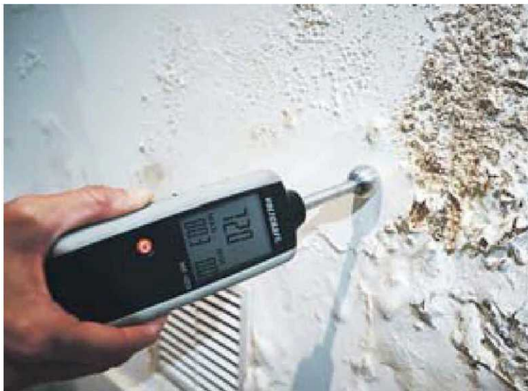
Aparato para medir la humedad en las paredes. :: usoz
